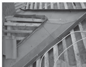
Вид конструкции в процессе монтажа
