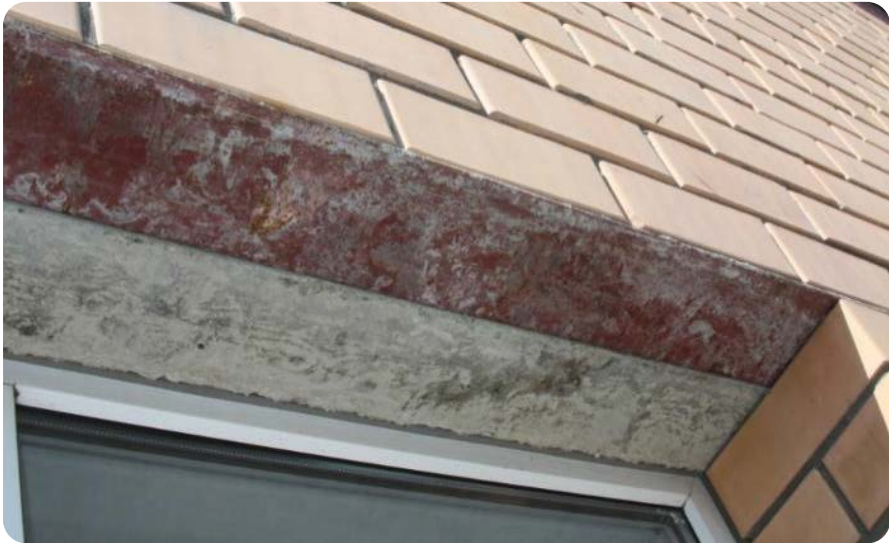
Внешний вид кладки без использования закладных деталей BRICKO
